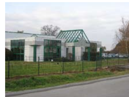
Bâtiment prochainement disponible sur le parc de la Peltière
